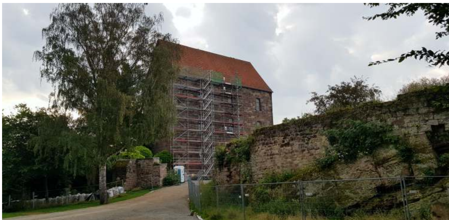
Sanierung des Muthauses Hardegsen
