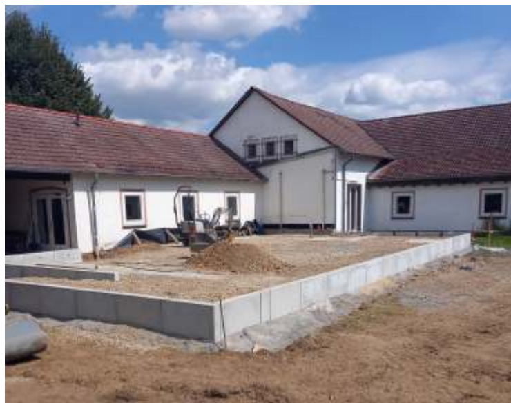
Die Arbeiten sind im vollen Gange.
