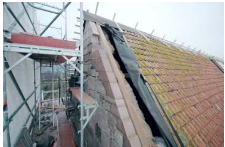
Südgiebel Vollendung Mauerwerk Ortgang
