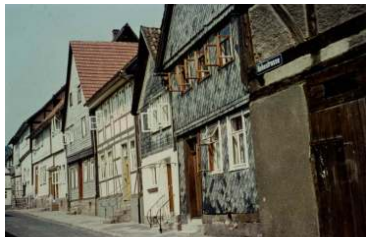
Die Hohestraße im Jahr 1965. Im vierten Haus von Rechts wohnte der letzte Fahlbusch in Hardeggen.
